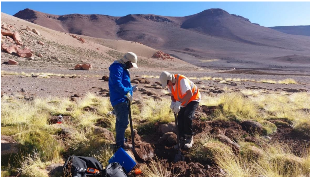
Fotografía 1. Excavación de calicata.
