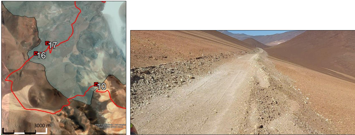
Figura 2-6. Puntos de Control indican sectores con riesgo de desbarrancamiento debido a estrechez del camino para tránsito de doble vía. Ancho medio del orden de 4 m. Detalle del camino en Punto de Control 10 (vista al oeste).
