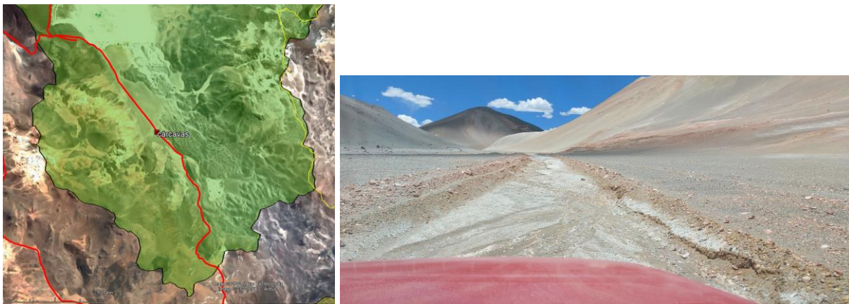
Figura 2-11. Cárcavas en caminos de la cuenca Salar de Gorbea. Similares hallazgos se observaron en la cuenca del Salar de La Isla.
