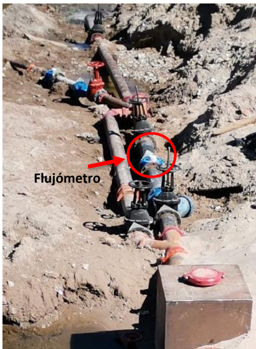
Figura 1. Ubicación Flujómetro.
