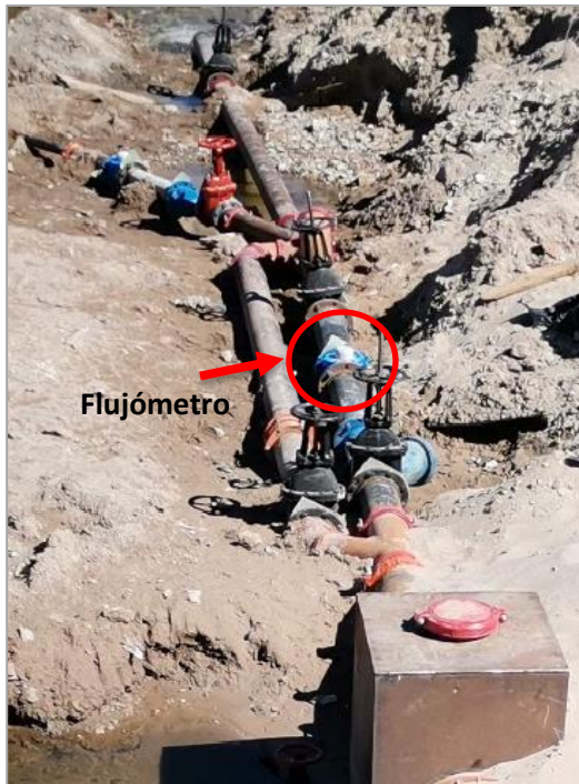
Imagen 2. Implementación Flujómetro en Tranque La Ola
