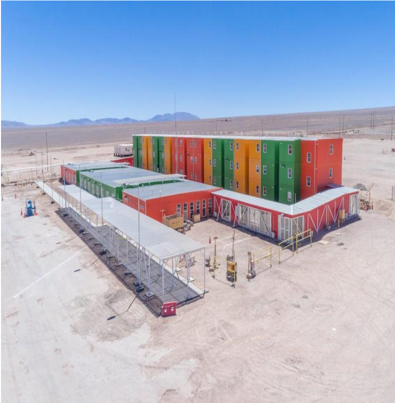
Fotografía N° 1 – Edificio Campamento existente
