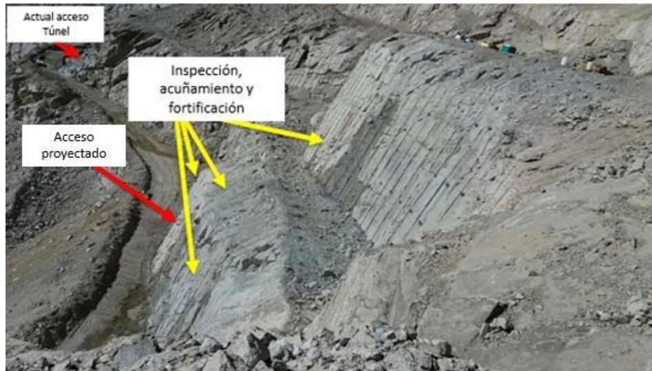
Fig.4: Acondicionamiento para inicio trabajos de excavación en roca
