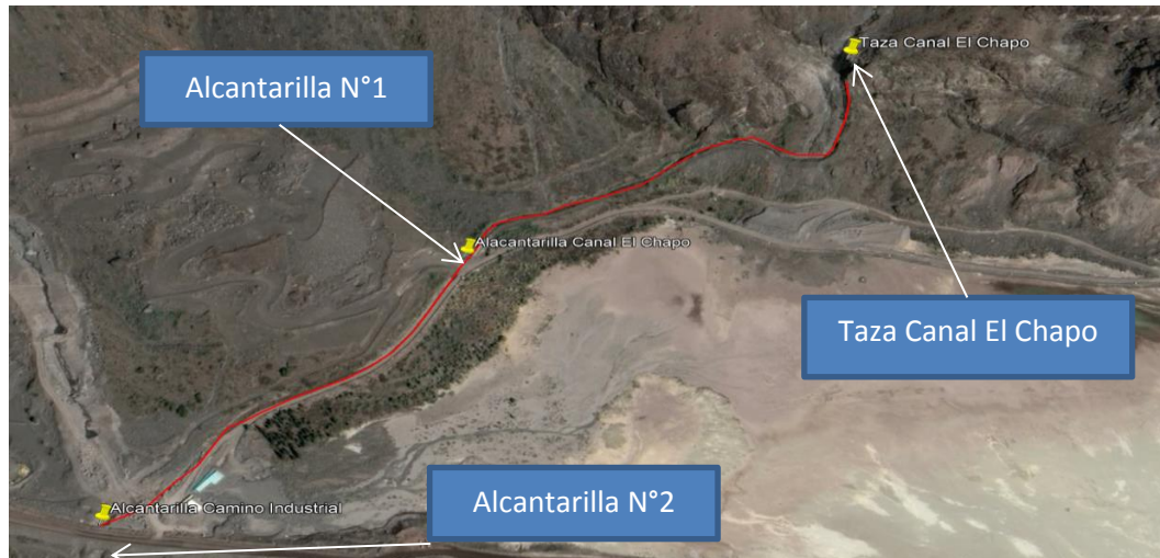
Figura N°1 Ubicación Obras Canal El Chapo
