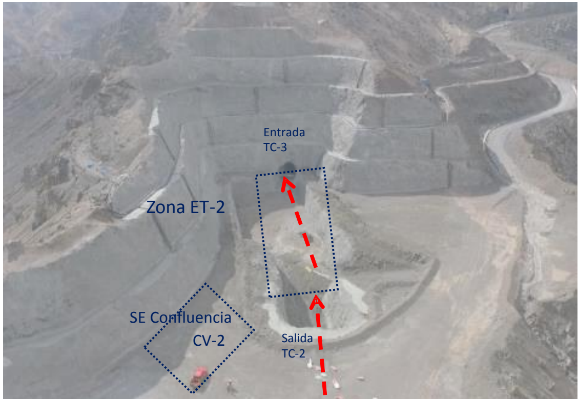
Figura N°3: Obras en Sistema CV-02.
