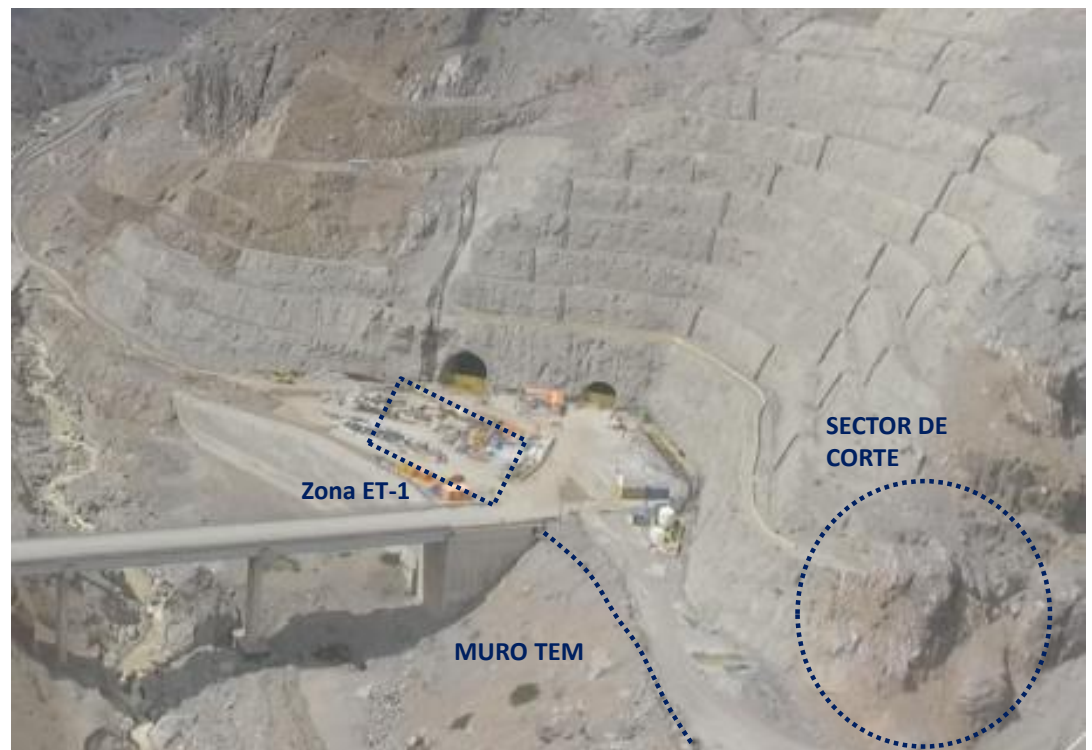
Figura N°2: Obras en Sistema CV-01.
