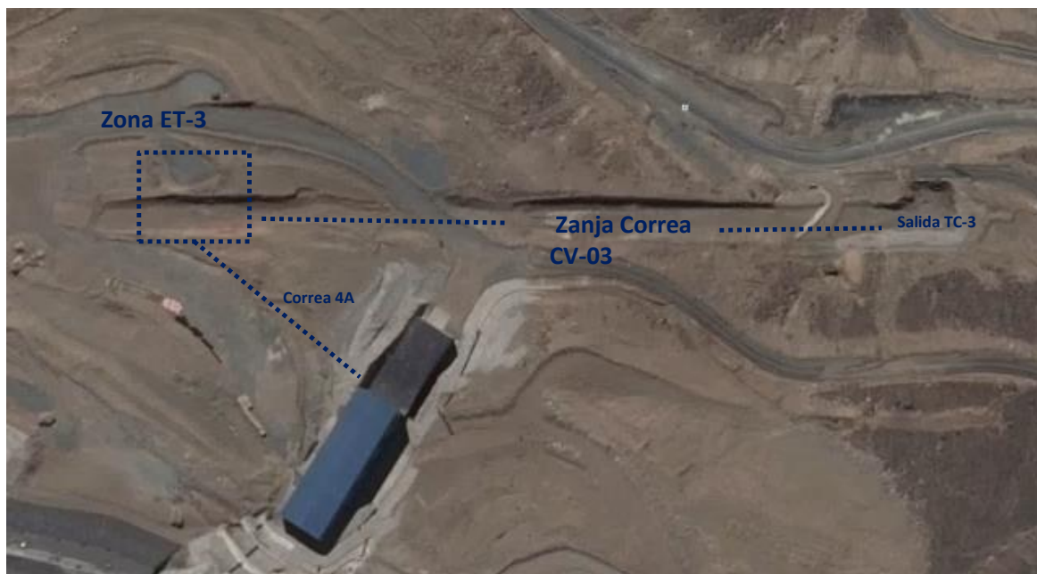
Figura N°4: Obras en Sistema CV-03 y CV-4ª
