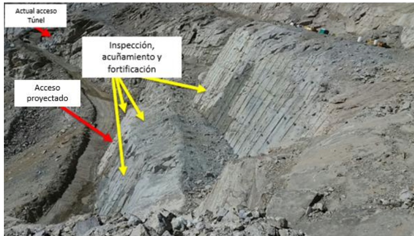
Figura 2: Acondicionamiento para inicio trabajos de excavación en roca
