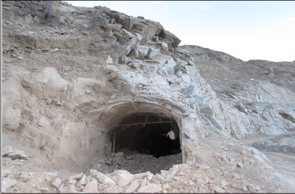
Figura 1: Condición actual Acceso Túnel Minera Sur Andes
