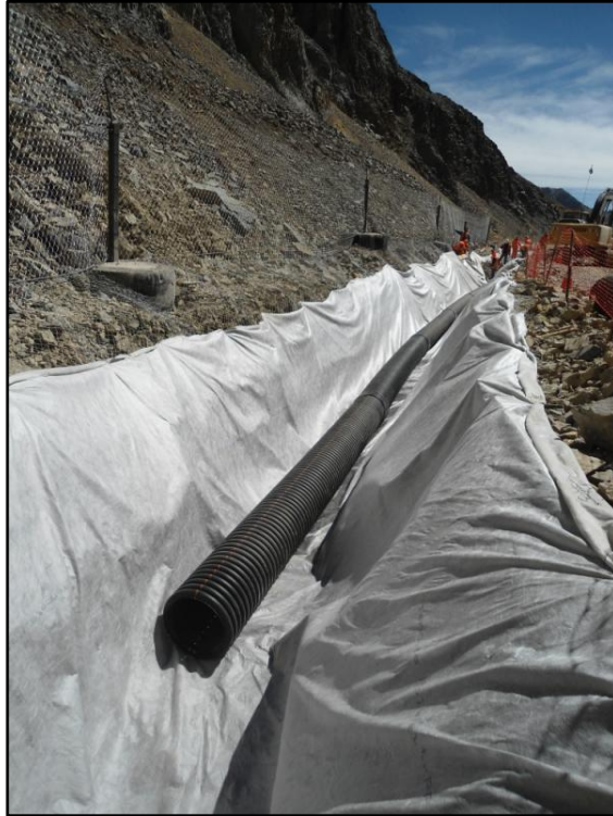
Ejemplo montaje dren existente
