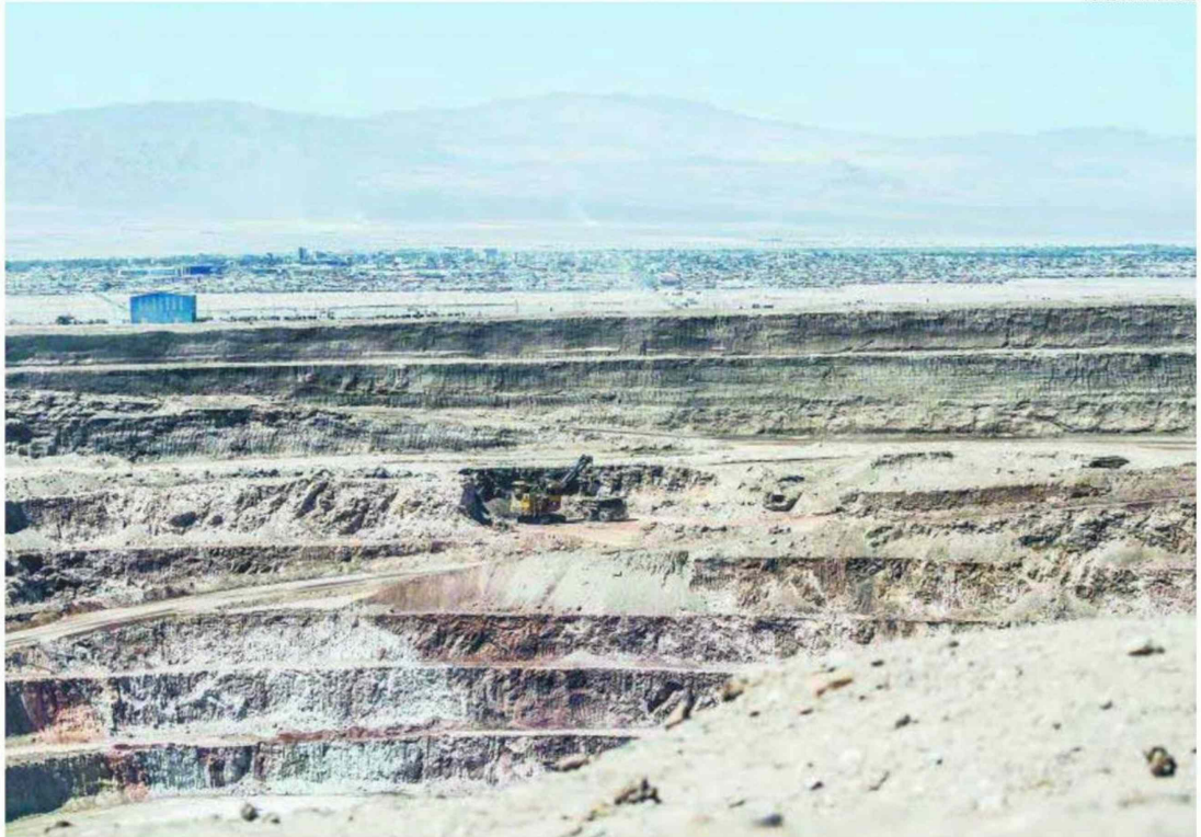
230 MILLONES DE TONELADAS DE MATERIAL ESTÉRIL FUERON REMOVIDAS PARA LA CONSTRUCCIÓN DEL RAJO DE LA DIVISIÓN MINISTRO HALES. EL MAYOR PRESTRIPPING DE LA HISTORIA.
