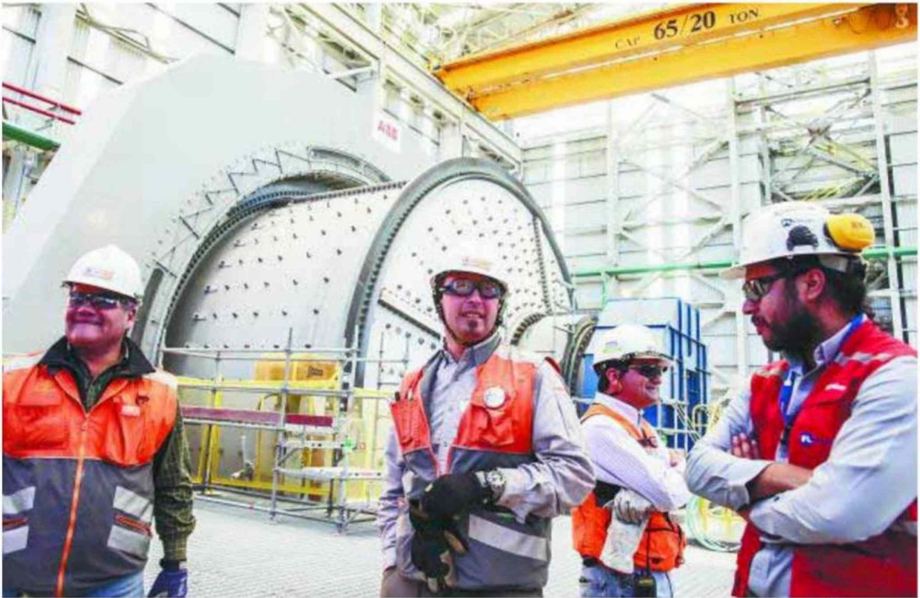
LA CONSTRUCCIÓN DE LAS PLANTAS COMENZÓ EN 2012. SE ESPERA QUE EN EL SEGUNDO TRIMESTRE DE 2014 LA OPERACIÓN ENTRE EN RÉGIMEN.
