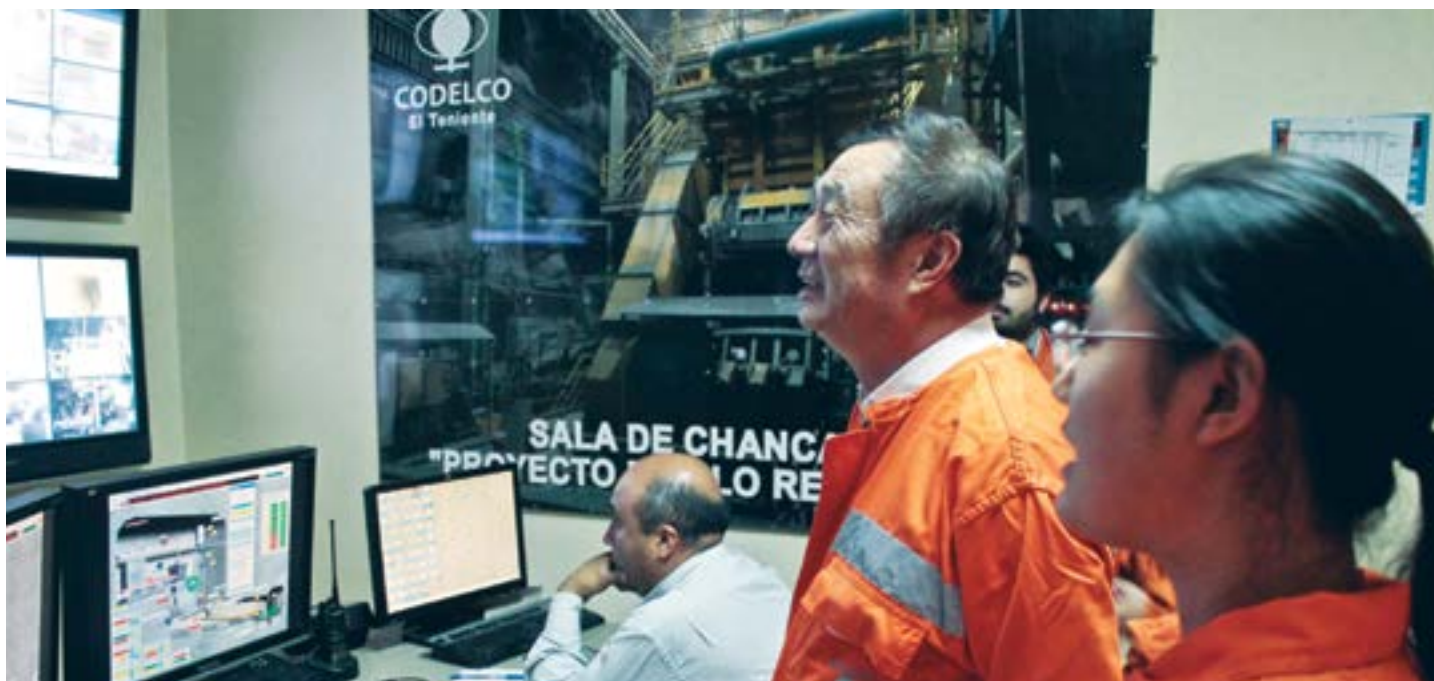
Ren Zhengfei y su comitiva conocieron las instalaciones tecnológicas que permiten operar remotamente maquinarias fundamentales para la operación.
