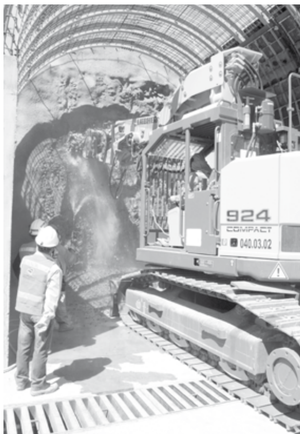
La Liebherr Compact 924 ya inició la perforación del Túnel PK 4600, que permitirá contar con cuatro frentes de trabajo para la construcción de los viaductos principales del Nuevo Nivel Mina.
