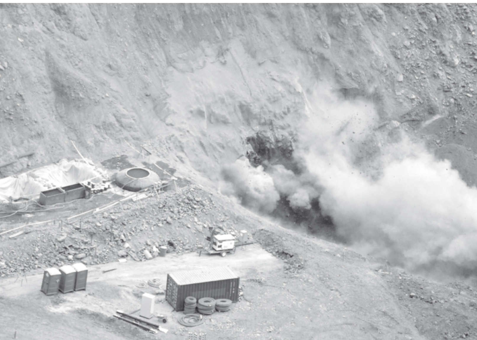
En la imagen, la primera detonación en la construcción de los túneles principales del proyecto Nuevo Nivel Mina, cerca de la Fundición de Caletones.
