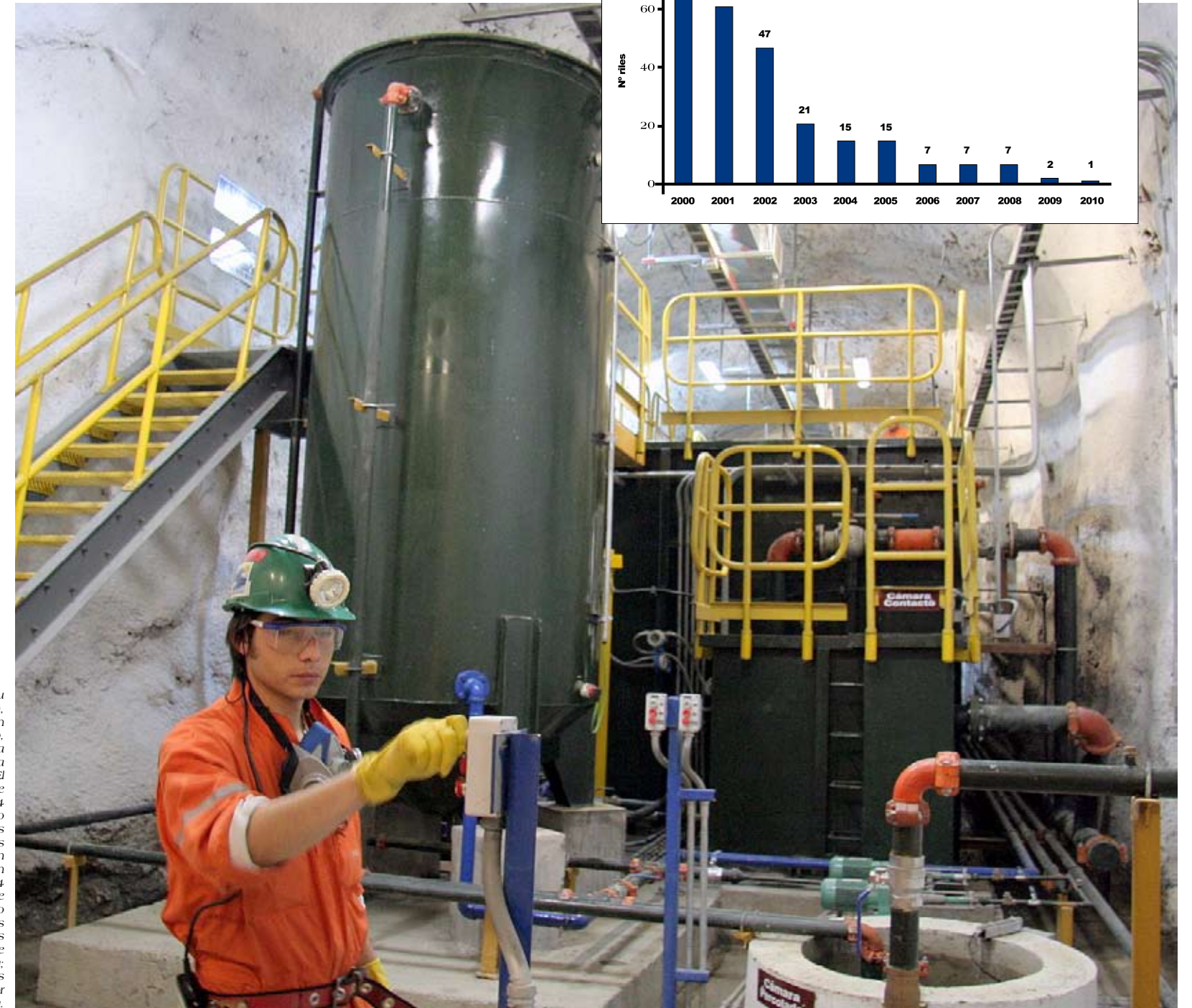
Mediante su eliminación, recirculación o tratamiento, en la última década División El Teniente bajó de 64 a sólo uno sus residuos industriales líquidos. En la División funcionan 14 plantas de tratamiento de aguas servidas como las de la fotografía; ocho de ellas en el interior de la mina.
