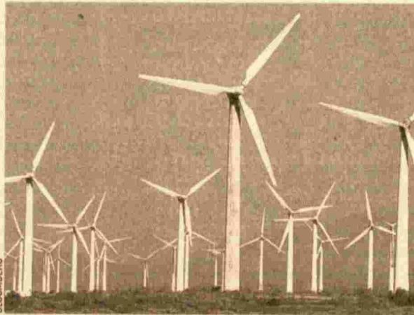
La denominada "granja eólica Calama" de Codeico, contempla la instalación de 125 aerogeneradores que producirán unos 250 MW.
