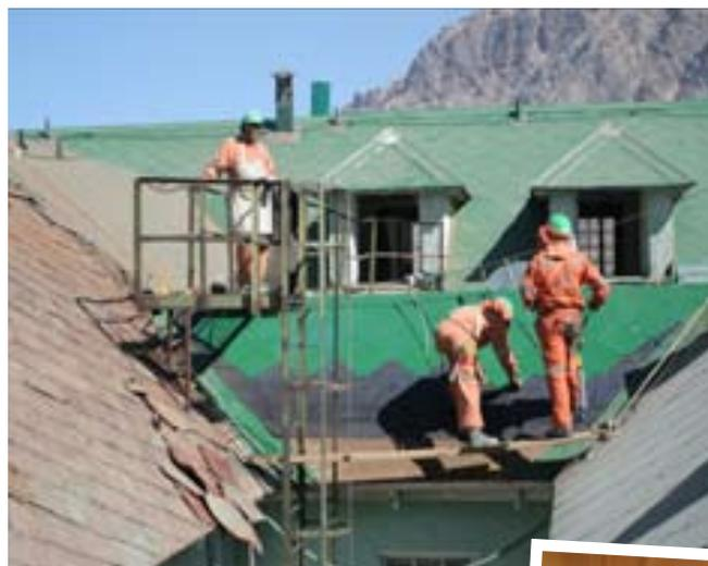
También, se realizó el cambio de cubierta en la techumbre del ex hospital (edificio 157) y trabajos de reparación de la escalera central.
