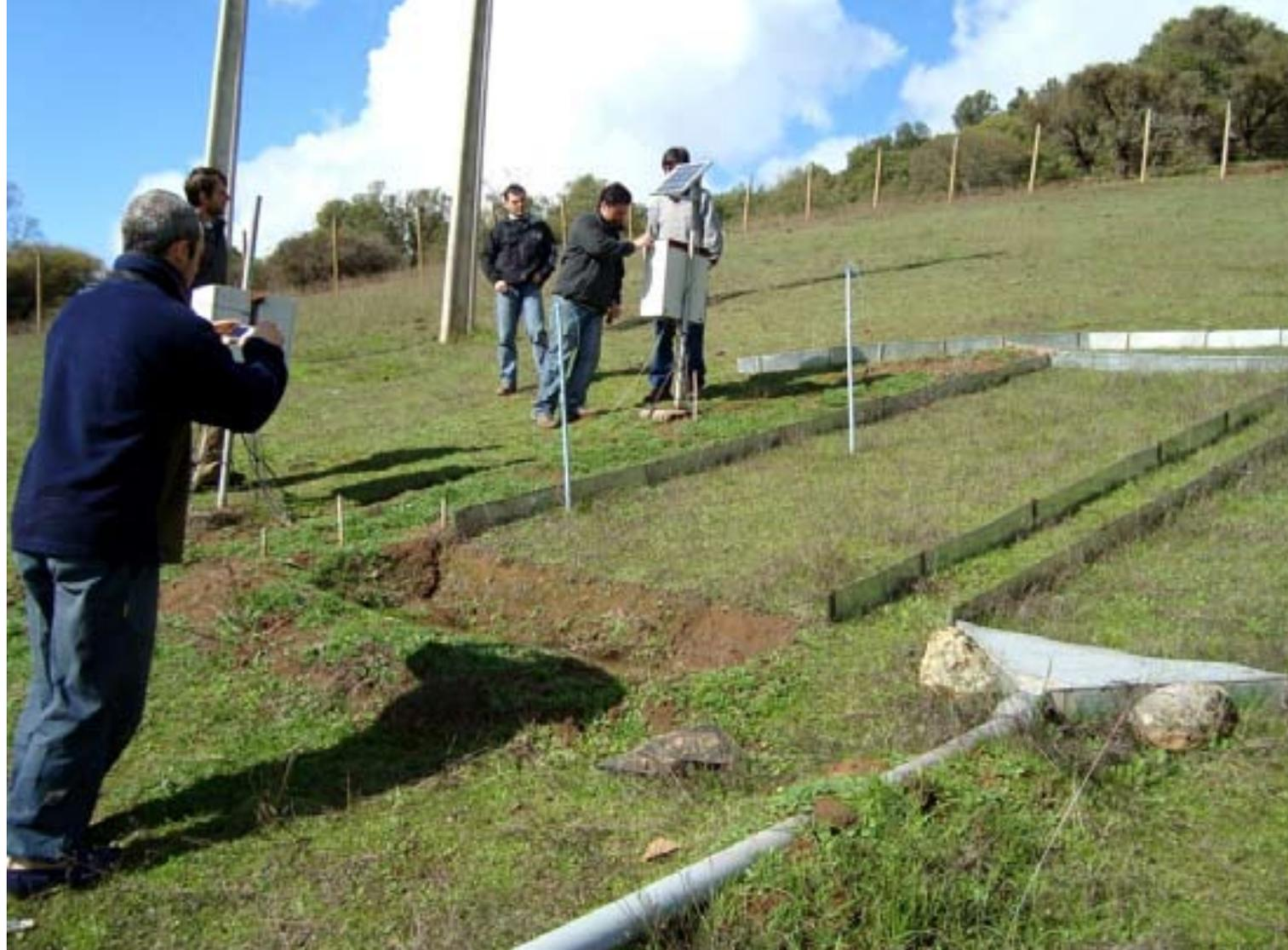
Estas "zanjas de infiltración" ubicadas en la Hacienda Ecológica Los Cobres de Loncha, permiten que las aguas lluvia no escurran por la ladera, permitiendo que la tierra pueda absorberlas.
