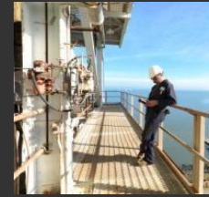
ENERGIA Y UTILITIES
