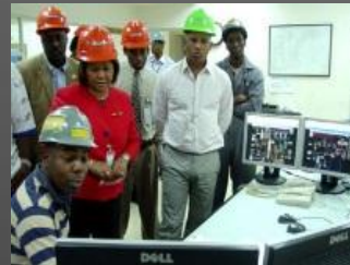
Sala de Control 2
