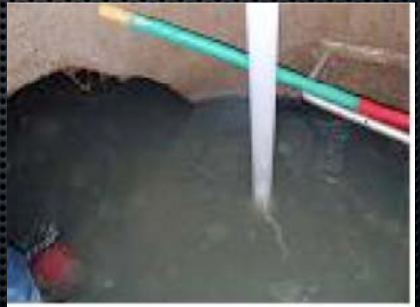
Instalación de Sensores en Alcantarillado
