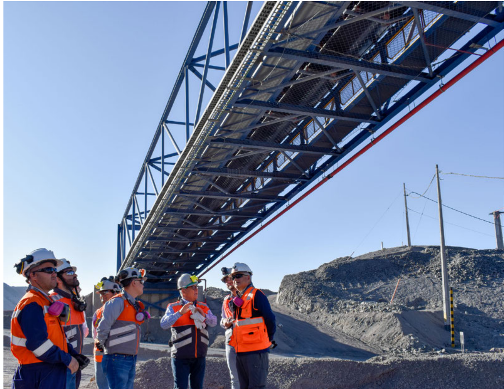
Correa de transporte de mineral, Chuquicamata Subterránea.
